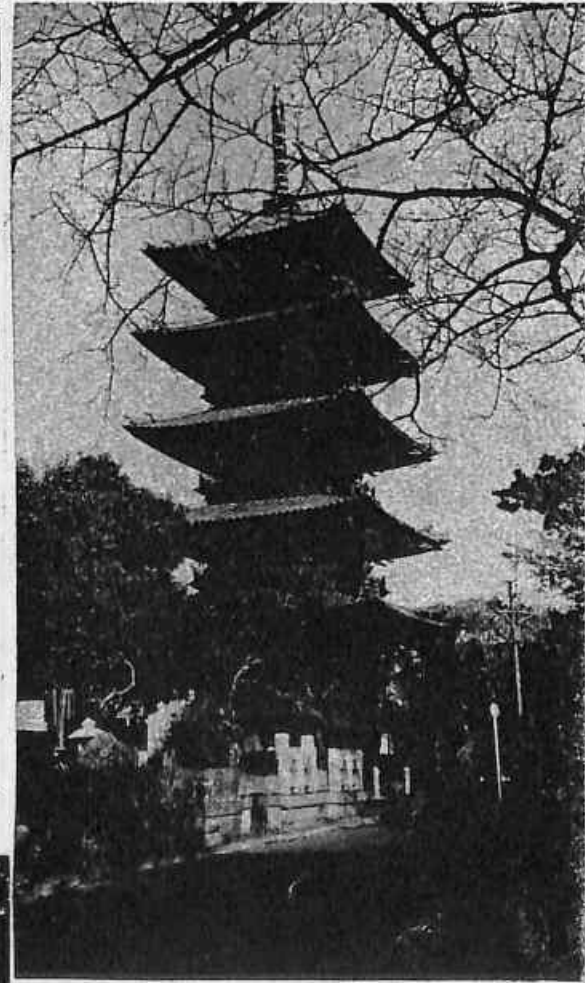
本門寺五重塔 東京 本門寺 三間五重塔姿 組物初重和様他重禅宗様各三手先 中備初重兼殿他重兼東 初重二軒繁垂木他重弱垂木 初・二重本瓦葺き、四重瓦葺銅板葺五重銅瓦葺 初重内部四天柱 来迎壁 仏壇 元禄十五年(1702)現在地に移築 二重以上は本格的禅宗様から成る 藝段に十二支を彫刻 桃山時代 慶長十二(1607)
